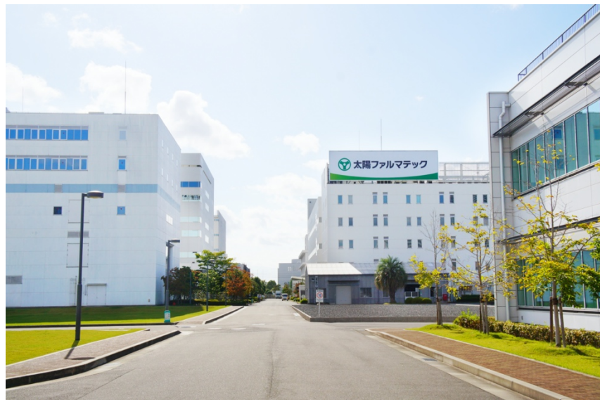
「FlexFactory」が導入される太陽ファルマテック株式会社の工場
